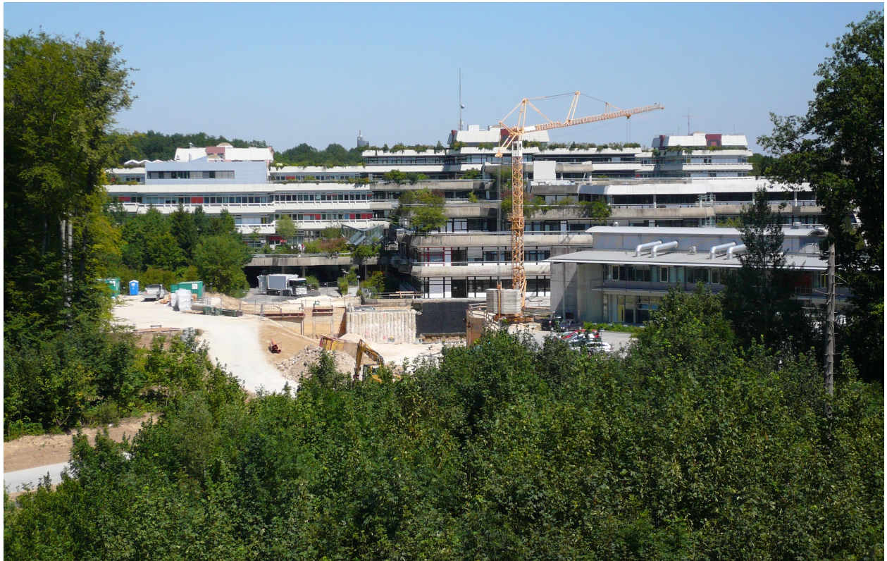
Betonbau der 70er Jahre: Die Uni Ost mit der Baustelle für die neue Chirurgie im Vordergrund.
