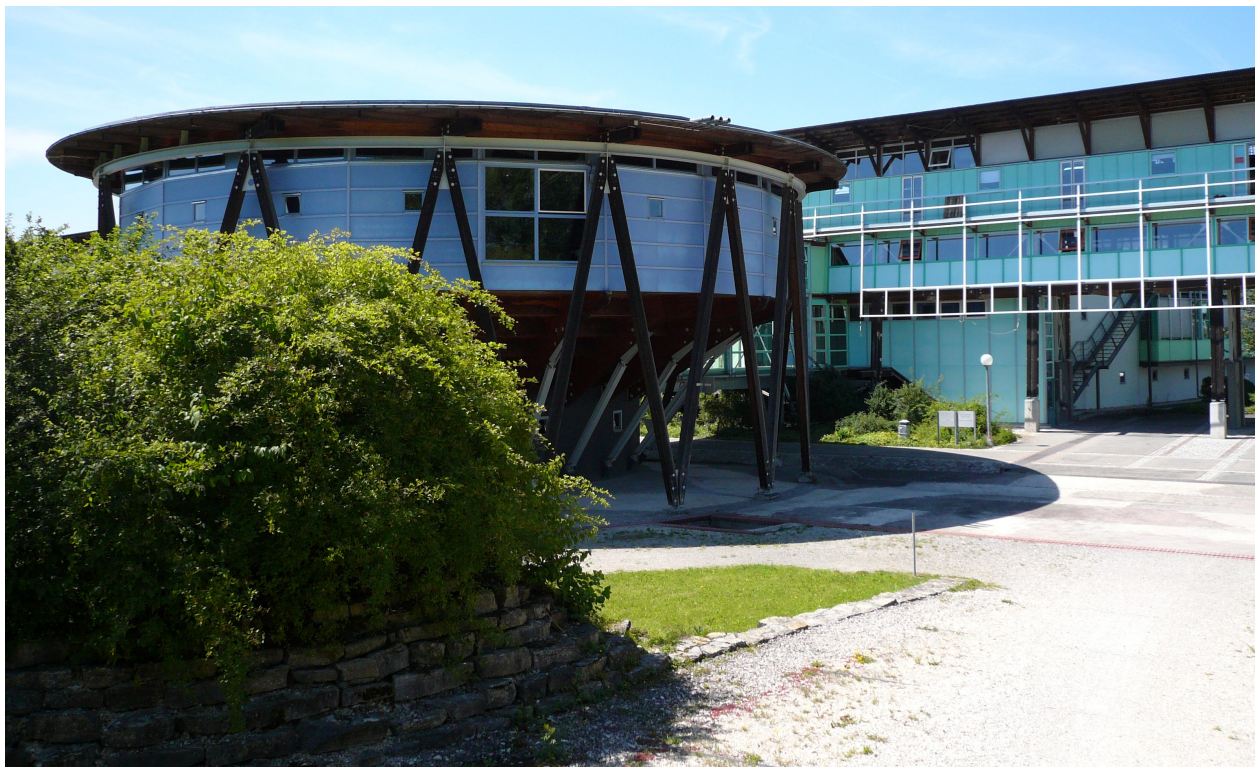
Holz ersetzt Beton: Die Uni West
